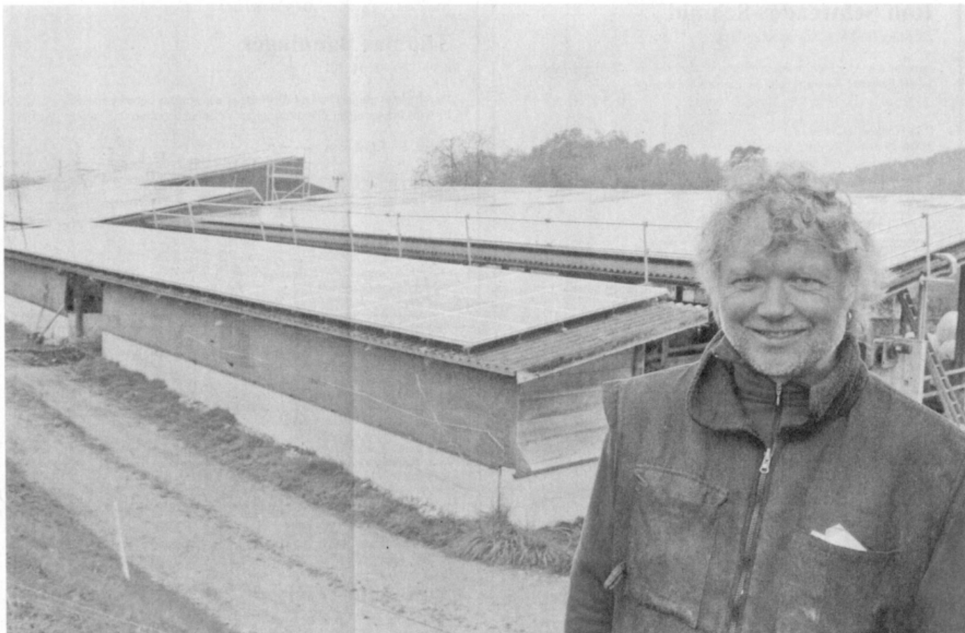
Viehstall mit Solardach: Ab sofort wird auf dem Bauernhof von Walter Schneller nicht nur Milch, sondern auch Strom produziert. Bild: Heinz Diener
